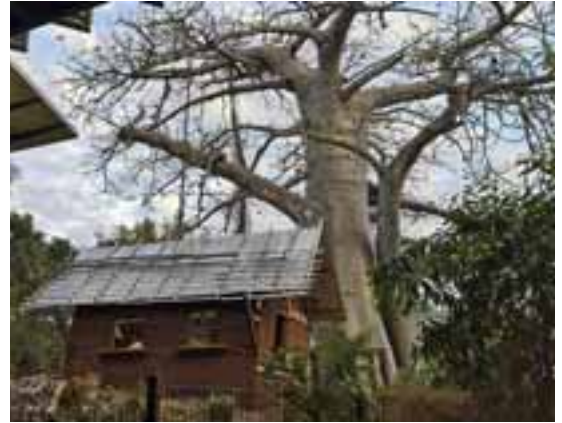
Figure 9 - Chantier d'apprentissage de construction d'un banga traditionnel, Collège de Boeni, Mayotte © Photo, Building For Climate, Nicolas Jobard, 2022
