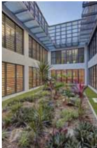
Figure 15 - vue du puits dépressionnaire. © H Douris
