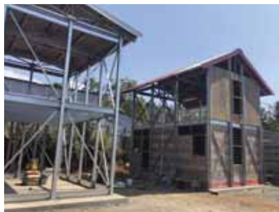
Figures 5 et 6 - Ossature métallique et BTC : chantier de Doujani en 2019 et logements Dembeni, 1999. Source : © agence Harappa
