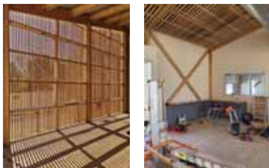
Figures 7 - Véranda avec écran et vue intérieure typique. © ATC Studio
